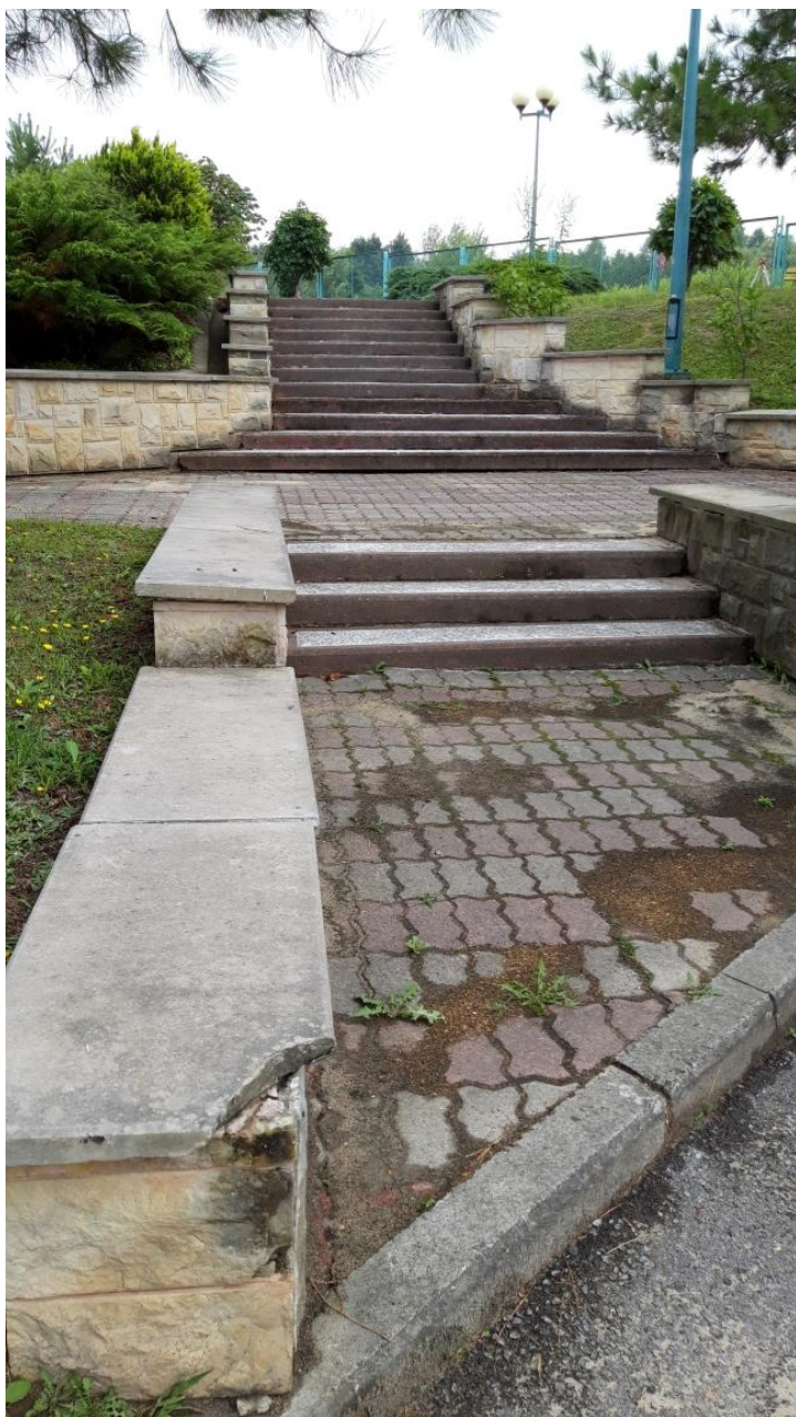
FOT. 14. SCHODY TERENOWE I MURKI OPOROWE
