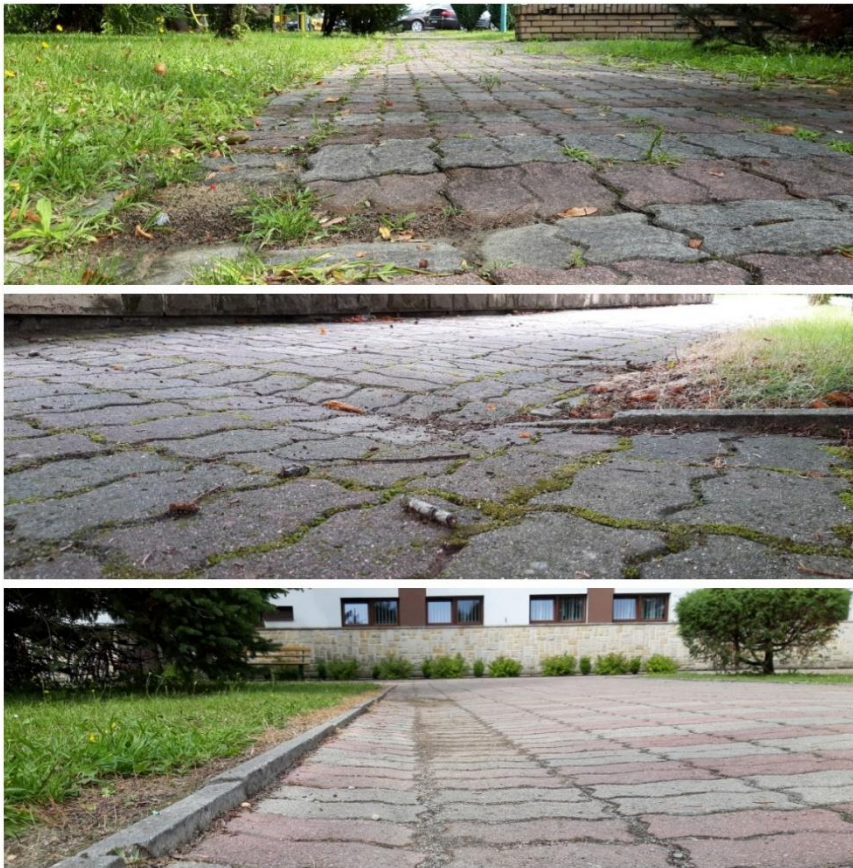
FOT. 13. CIĄGI PIESZE
