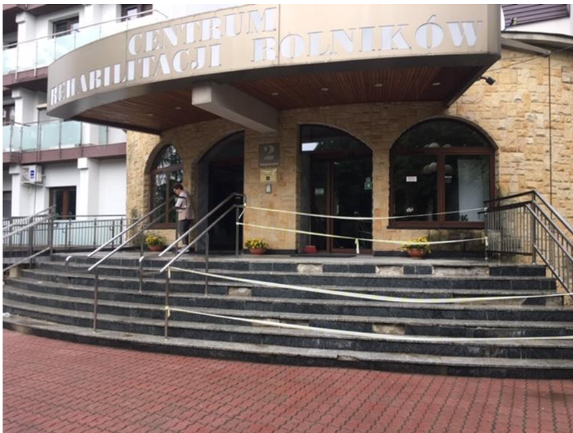
Fot. 1. SCHODY GŁÓWNE WEJŚCIOWE DO BUDYNKU
