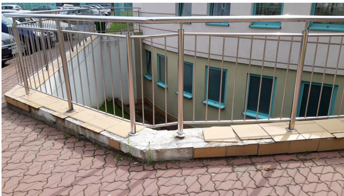
FOT. 9. COKOLIK PRZY WEJŚCIU DO BUDYNKU BASENU
