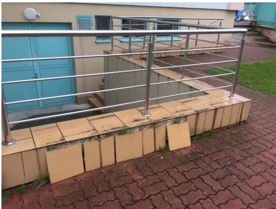
Fot. 8. SCHODY DO PODBASENIA (cokolik)
