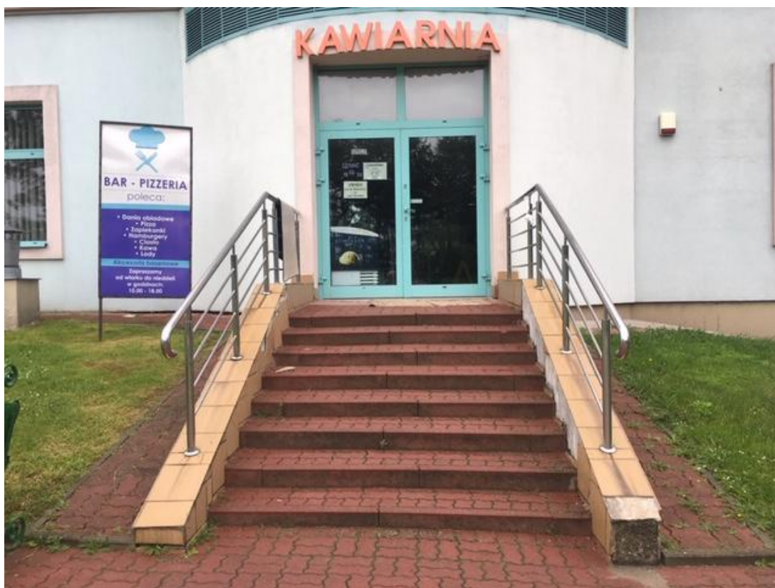
Fot. 2. SCHODY WEJŚCIOWE DO KAWIARNI
