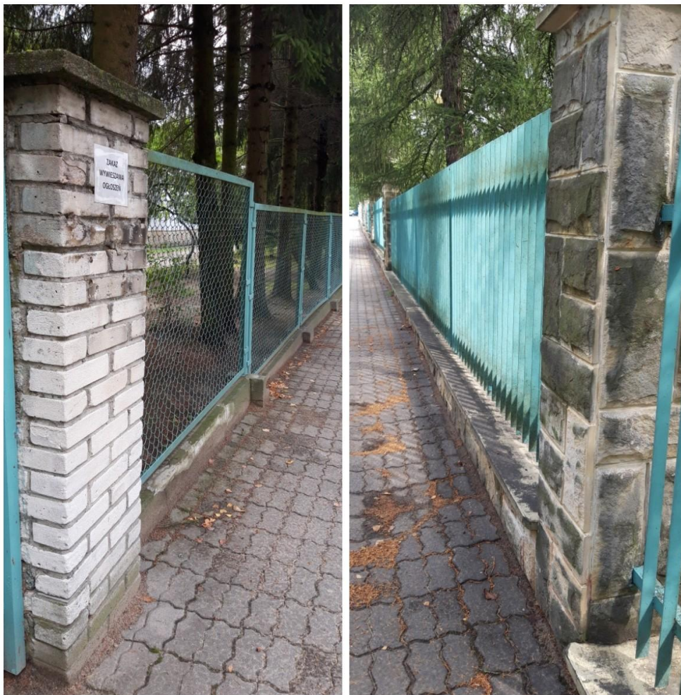
FOT. 10. OGRODZENIE PRZED BUDYNKIEM ROLNIK I I ROLNIK II
