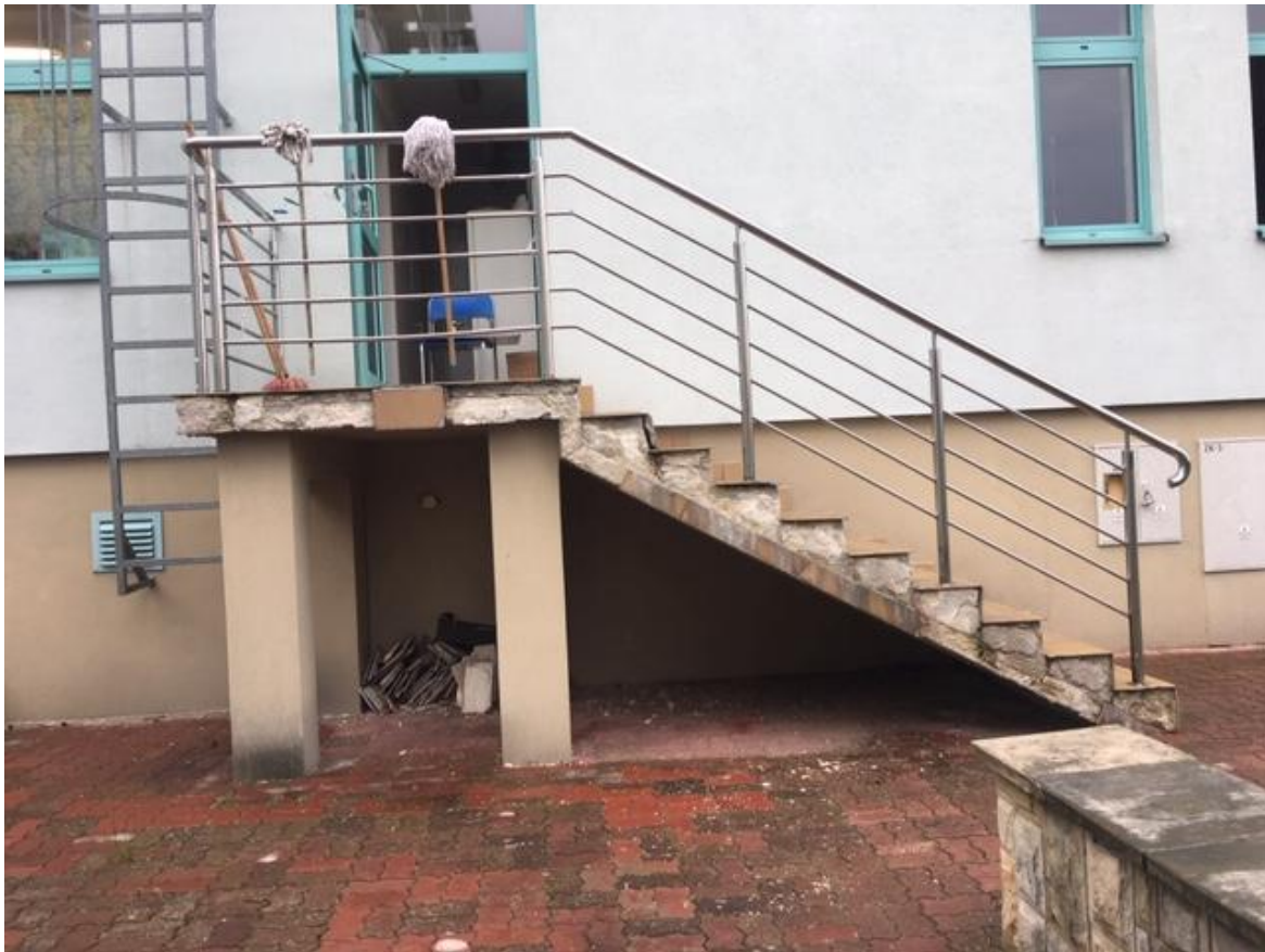
Fot. 5. SCHODY EWAKUACYJNE Z KAWIARNI (OD STRONY POŁUDNIOWEJ):
