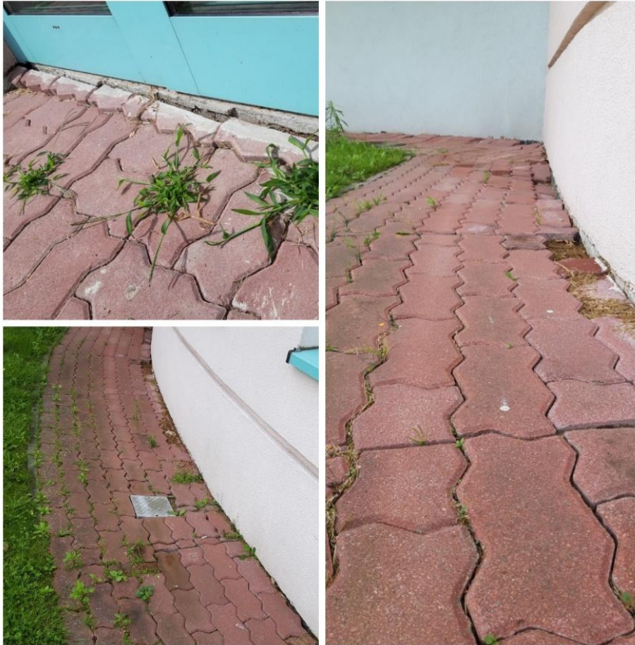
FOT. 16. PŁYTKA ODOJOWA PRZY BUDYNKU Z BASENU
