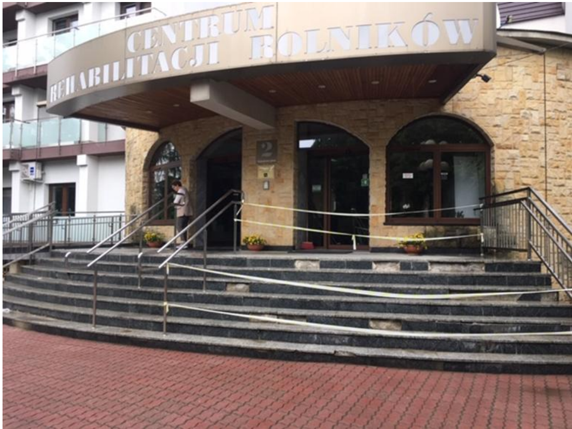
Fot. 1. SCHODY GŁÓWNE WEJŚCIOWE DO BUDYNKU
