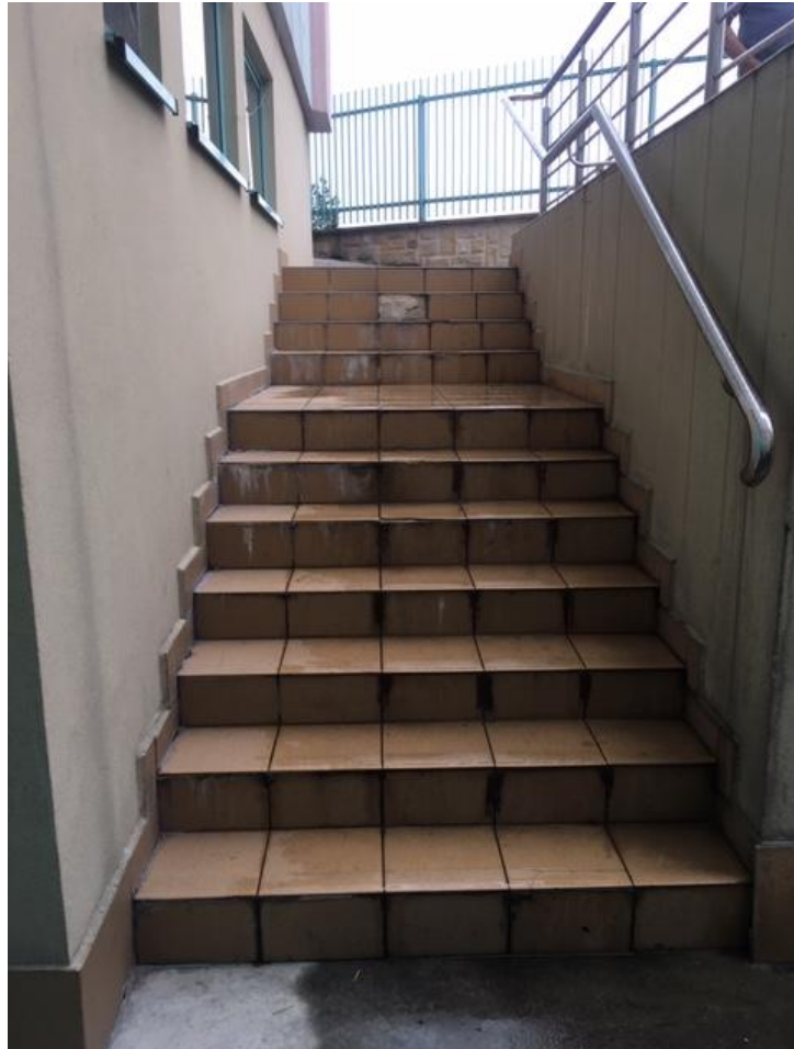
Fot. 7. SCHODY DO PODBASENIA
