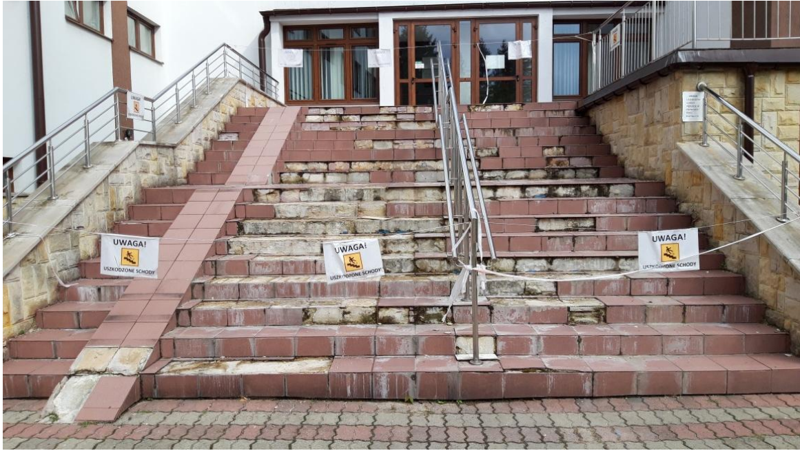
Fot. 3. SCHODY WEJŚCIOWE DO BUDYNKU ROLNIK 1 OD STRONY POŁUDNIOWEJ /Z TARASEM/
