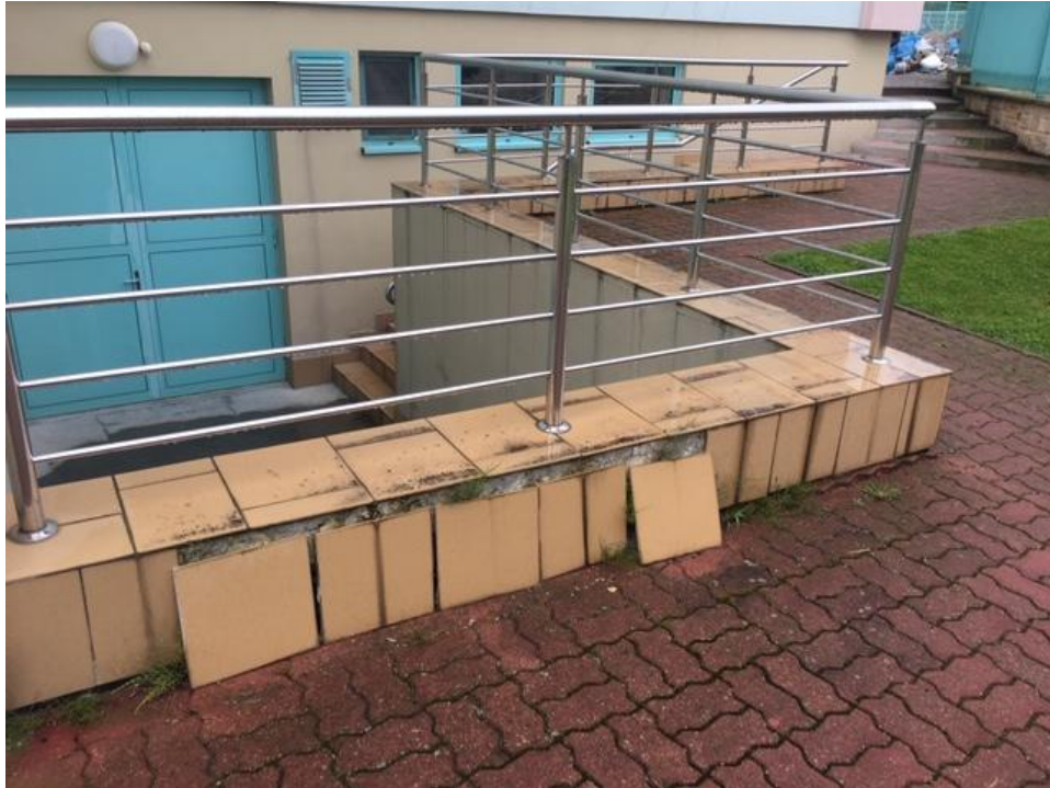
Fot. 8. SCHODY DO PODBASENIA (cokolik)
