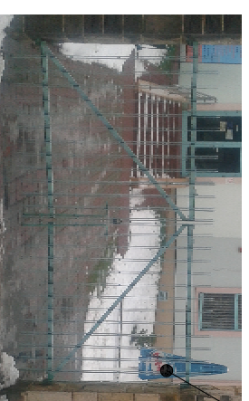
czyszczenie mechaniczne + malowanie przęseł bramowych
