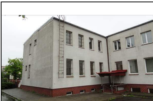
Fot. 3. Widok budynku od strony południowo - zachodniej
