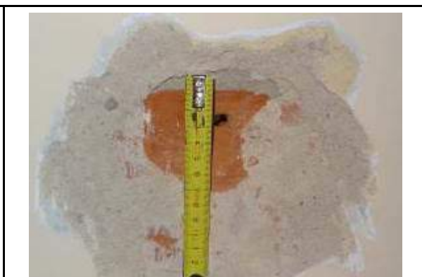
Fot. 78. Szczegół odkrywki ścianki działowej z cegły dziurawki.
