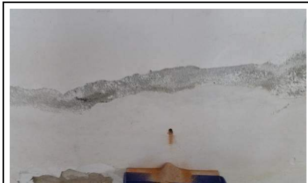
Fot. 59. Odwiert kontrolny ścian wewnętrznych piwnicy wykazała zastosowanie cegły ceramicznej pełnej.
