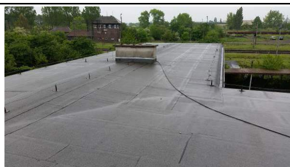
Fot. 9. Widok powierzchni dachu pokrytej papą termozgrzewalną.
