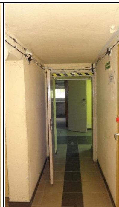
Fot. 106. Widok rozprowadzenia przewodów instalacji elektrycznej na tynku w korytarzu piwnicy.
