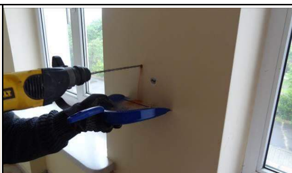
Fot. 76. Odwiert kontrolny filarka ściany zewnętrznej części dobudowywanego budynku, wykazała zastosowanie bloczków ceramicznych i silikatowych.
