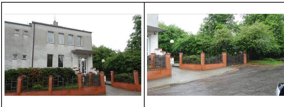
Fot. 1. Widok budynku od strony północnej – elewacja frontowa
