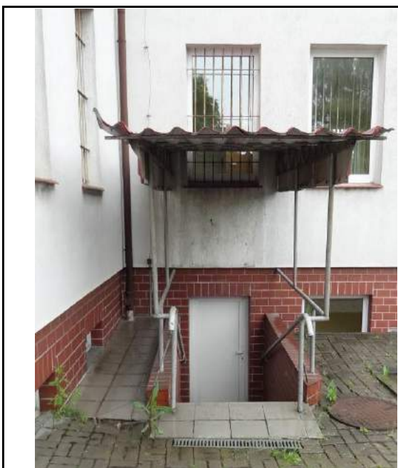
Fot. 7. Widok wejścia do piwnicy z podwórza
