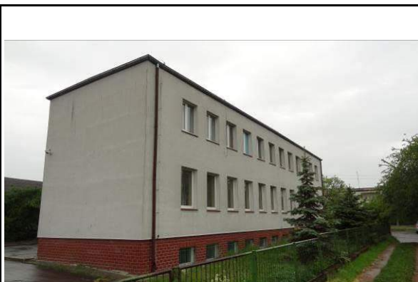
Fot. 4. Widok budynku od strony wschodniej
