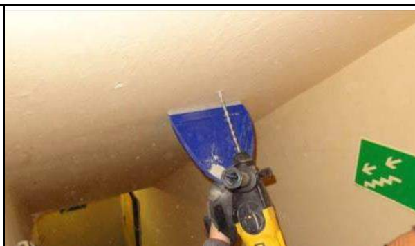
Fot. 72. Odwiert kontrolny biegu schodowego betonowego do piwnicy.
