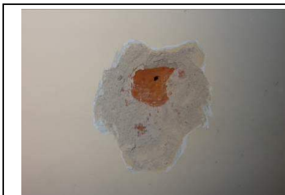
Fot. 77. Widok odkrywki ściany działowej z cegły dziurawki murowanej na sztorc.
