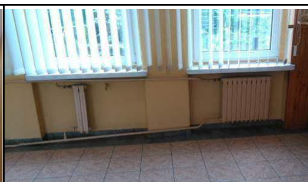
Fot. 100. Widok częściowo zdemontowanego grzejnika stalowego w sali posiedzeń na parterze.
