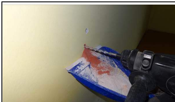
Fot. 73. Odwiert kontrolny ściany nośnej wewnętrznej części starszej budynku wykonanej z cegły ceramicznej pełnej.
