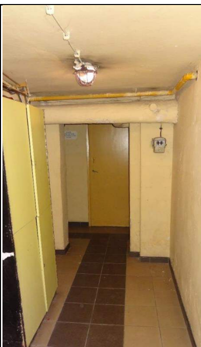
Fot. 105. Widok rur instalacji gazowej i c.o. oraz starych opraw oświetleniowych korytarza piwnicy z doprowadzeniem przewodów na tynku.
