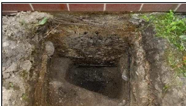
Fot. 41. Widok ściany fundamentowej w starszej części budynku w miejscu wykonania odkrywki.
