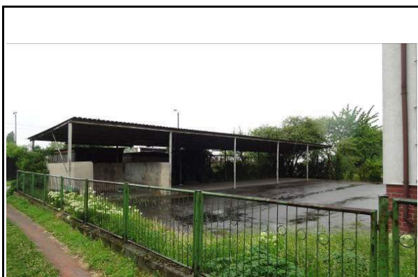
Fot. 5. Widok wiaty na posesji zlokalizowanej od strony południowej budynku
