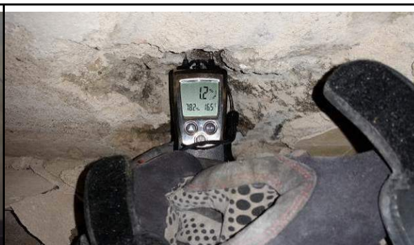
Fot. 64. Pomiar wilgotności ściany zewnętrznej piwnicy.
