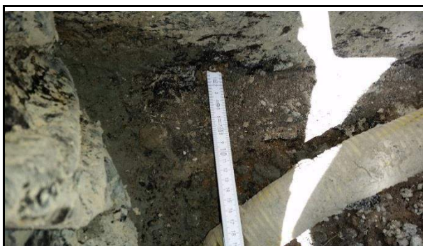
Fot. 45. Widok zaślepionej rury drenażowej w miejscu wykonania odkrywki.
