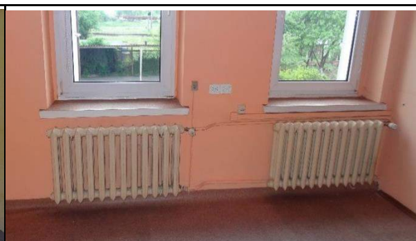
Fot. 98. Widok istniejącej instalacji telefonicznej i logicznej z przewodami poprowadzonymi na tynku i w naściennych rurach osłonowych.
