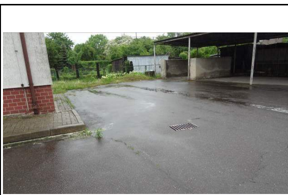
Fot. 6. Widok placu i wiaty na posesji zlokalizowanego od strony południowej budynku.
