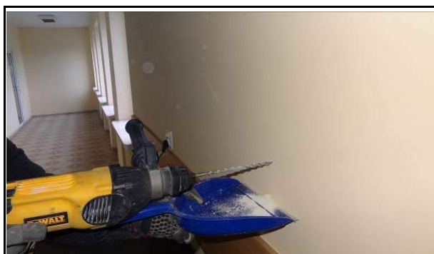
Fot. 75. Żużlobeton i bloczki silikatowe w miejscu wykonania odkrywki w ścianie wewnętrznej pomiędzy częścią starszą budynku a dobudowywaną.
