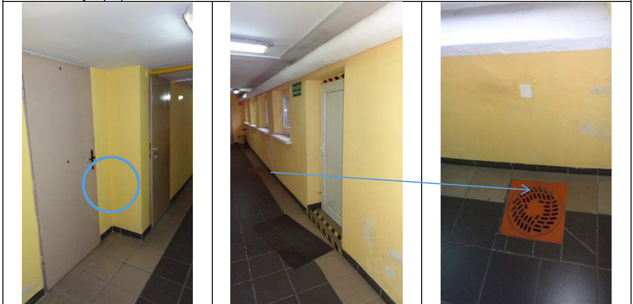
Pom 0.3 – korytarz wyjście na zewnątrz
