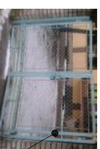
czyszczenie mechaniczne + malowanie przęseł bramowych
