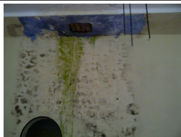
Fot. 6. Widoki zagrzybienia na sufitach i ścianach
