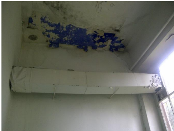
Fot. 7. Widoki zagrzybienia na sufitach i ścianach A) kuchnia, odpadający tynk ze stropu kleina, grzyb i glony na ścianach i suficie B) pom. pomocnicze kuchni – odpadający tynk, grzyb na ścianach i suficie C) pom. pomocnicze kuchni – strop z płyt panwiowych, grzyb na ścianach i suficie
