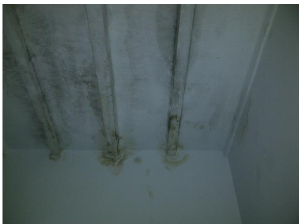
Fot. 7. Widoki zagrzybienia na sufitach i ścianach A) kuchnia, odpadający tynk ze stropu kleina, grzyb i glony na ścianach i suficie B) pom. pomocnicze kuchni – odpadający tynk, grzyb na ścianach i suficie C) pom. pomocnicze kuchni – strop z płyt panwiowych, grzyb na ścianach i suficie
