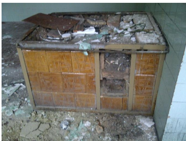
Fot. 8. Widoki pomieszczeń A) kuchnia - zdewastowane kuchnie węglowe B) kuchnia - zdewastowana kuchnie węglowa C) sala stołówki zbutwiałe deski, odpadający tynk, grzyb na ścianach i suficie, powyrywana instalacja elektryczna, wraz z lampami
