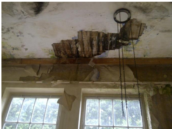
Fot. 8. Widoki pomieszczeń A) kuchnia - zdewastowane kuchnie węglowe B) kuchnia - zdewastowana kuchnie węglowa C) sala stołówki zbutwiałe deski, odpadający tynk, grzyb na ścianach i suficie, powyrywana instalacja elektryczna, wraz z lampami
