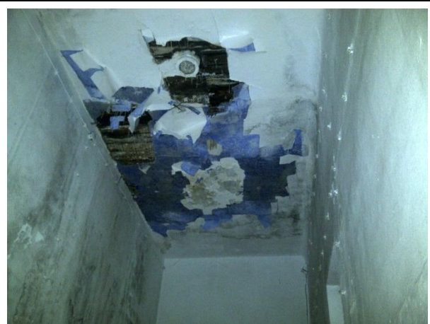
Fot. 6. Widoki zagrzybienia na sufitach i ścianach
