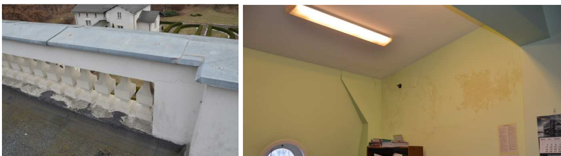
Fot 13, 14 Widok poszycia dachowego i zawilgocenia ściany II piętra (poddasza).
