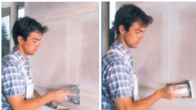
Etapy wykańczania połączeń płyt.
